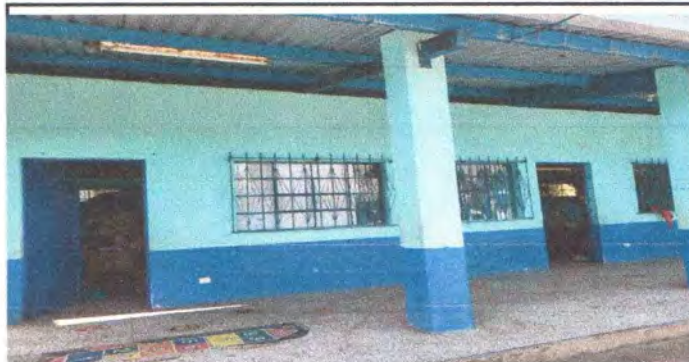
Foto 6: Pintura en exteriores e interiores.
