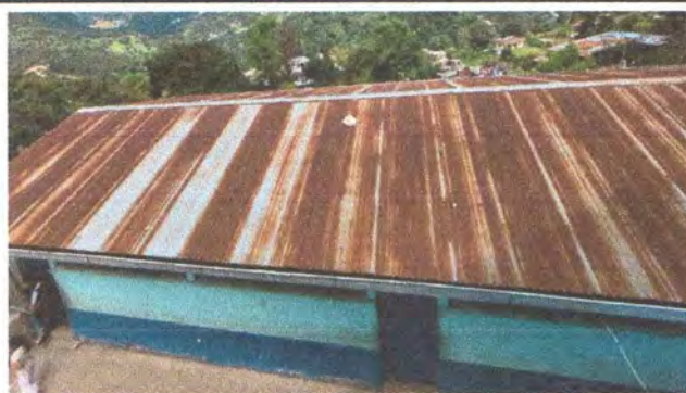
Foto 2: Sustitución de lámina y capotes.
