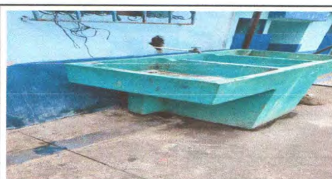
Foto 12: Sustrución de pila de cemento de dos lavaderos.
