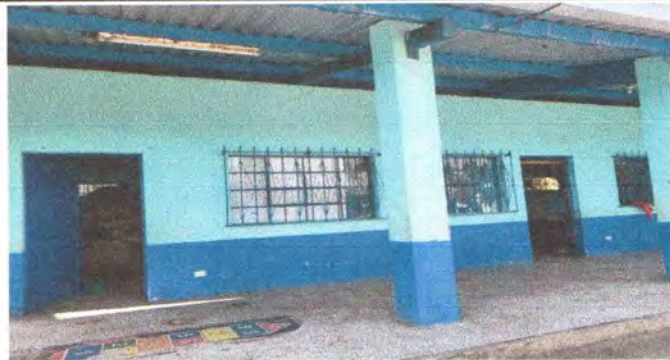
Foto 14: Reparación de paredes (aulas)
