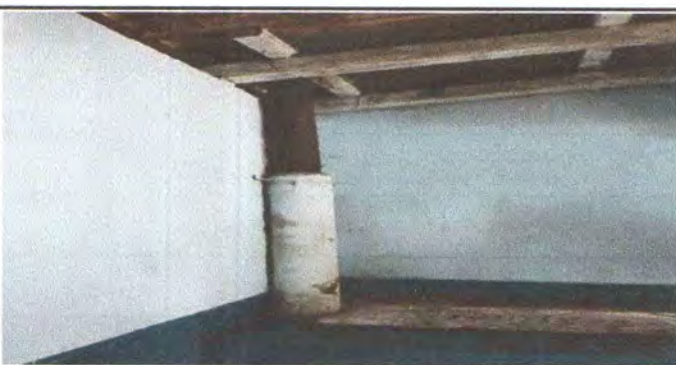
Foto 11: Sustrución de chimeneas de concreto.
