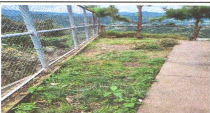
Foto 10: Reparación de planchas de concreto de patio.
