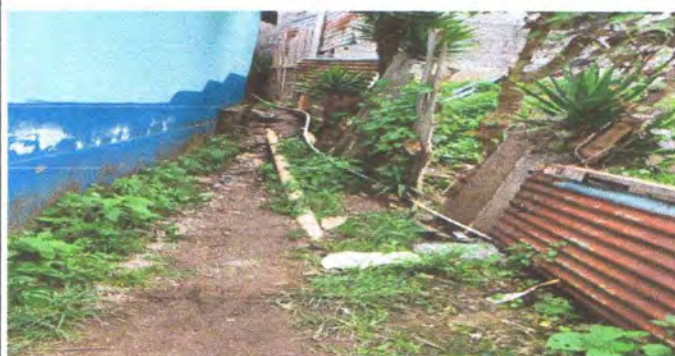
Foto 8: Sustrución de tubería PVC línea principal de aguas negras.
