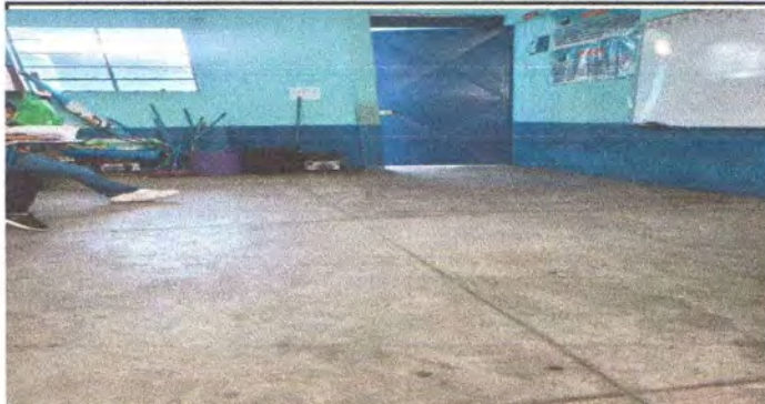
Foto 4: Sustitución de piso de cemento líquido.
