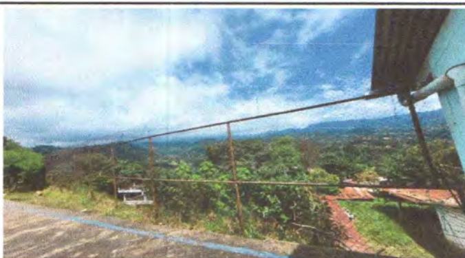
Foto 9: Reparación de muro perimetral.
